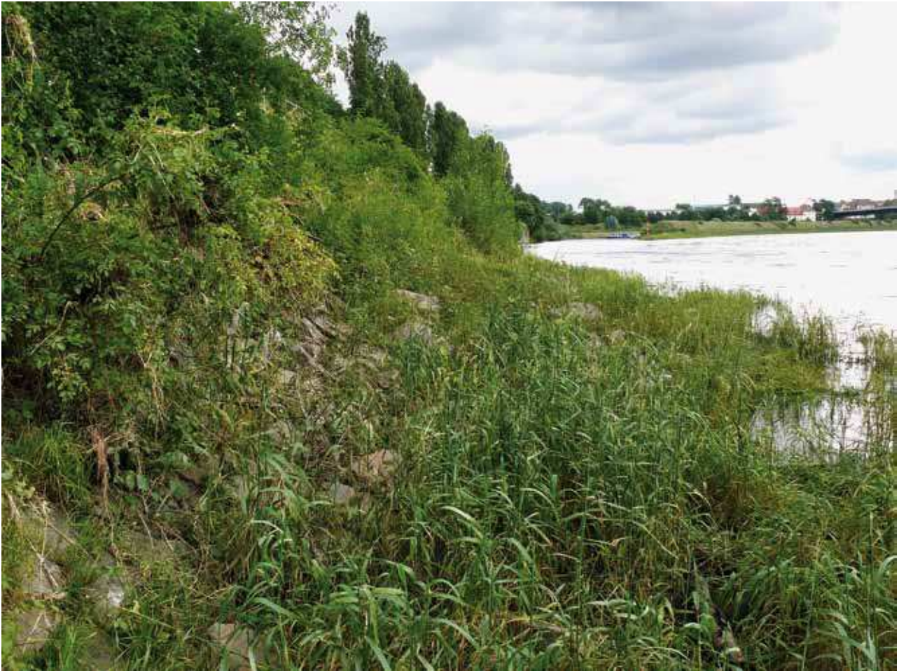
Abb. 11. Die Steinbefestigung des Uferhabitats war teilweise mit Beton versiegelt, ist aber wie hier über große Flächen lückig gefügt, Juni 2010. Foto: KONRAD MEBERT.
